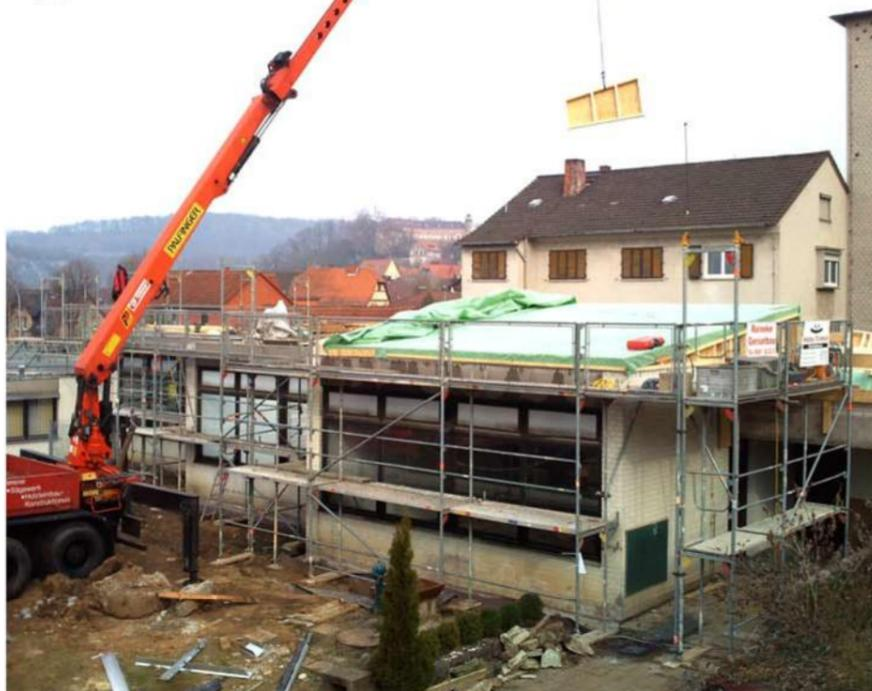
Neue Gefälledachkonstruktionen - Montage der vorgefertigten Elemente
